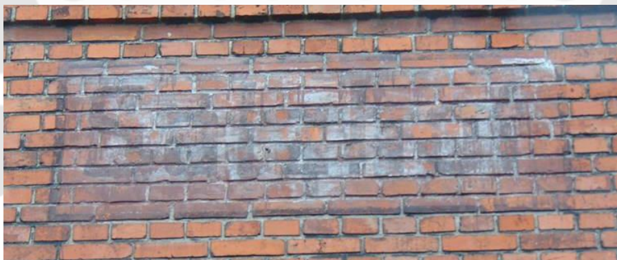
Napis SALZHOF (nazwa Wapna w czasach okupacji niemieckiej 1939-1945) na budynku kolejowym, Fot. Jakub Linetty
