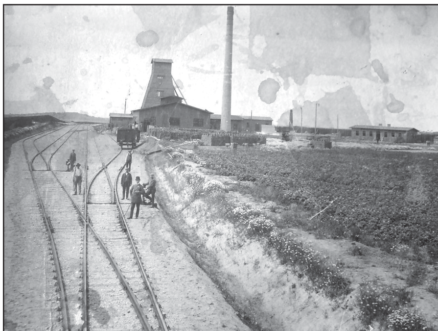
Początki budowy kopalni soli - bocznicza kolejowa. Na pierwszym planie z laską szytgar Ryszard Czerlin.
